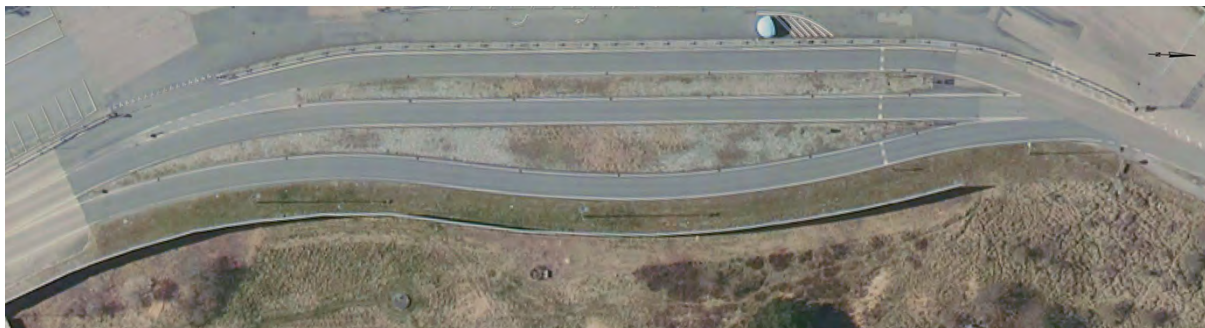
Figur 2: Eksisterende forhold ved udkørsel fra havneområdet.
